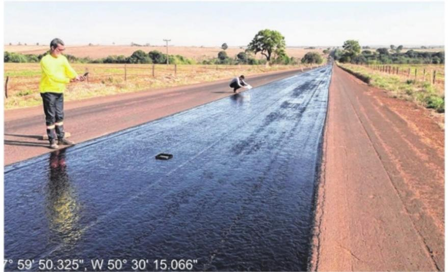
dovia BR-452, está recebendo os serviços de revestimento asfáltico (fresagem) e imprimação (aplicação de camada de material asfáltico sobre a superfície da base), além de reparos localizados nos 57,7 Km de sua extensão.
