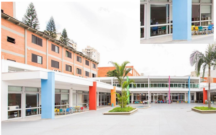
▷ COBERURA PLAYGROUND Estrutura Metálica pilares e vigas Pilares que sobresaem da viga Pintados coloridos
