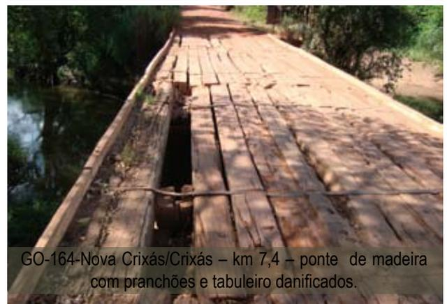
GO-164-Nova Crixás/Crixás - km 7,4 - ponte de madeira com pranchões e tabuleiro danificados.
