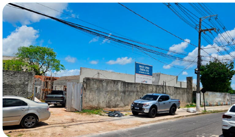
Visita à obra da Creche em Ananindeua/PA
