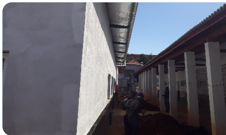
Detalhe da telha termoacústica da cobertura do refeitório
