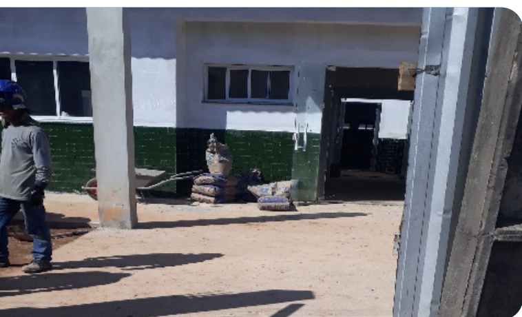
Detalhe dos desníveis para acesso à escola
