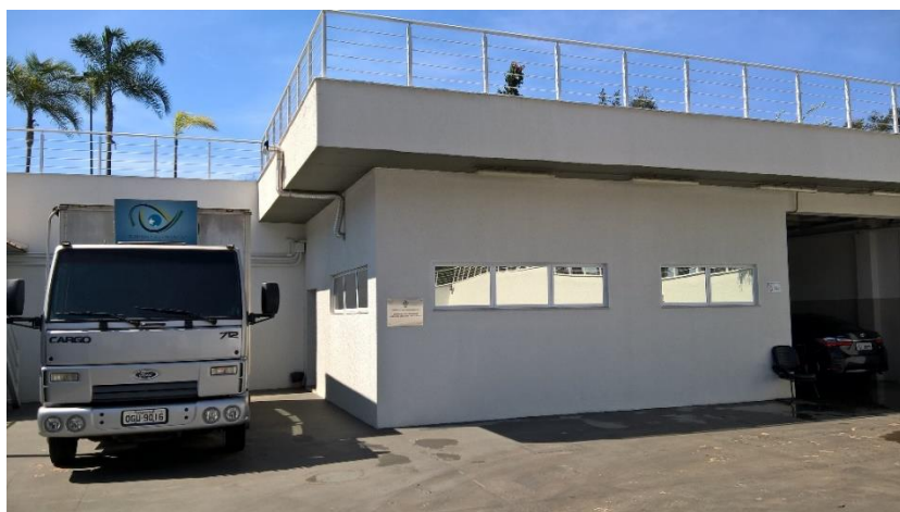
Figura 14. Exterior do Laboratório Engº Éden Maluf
